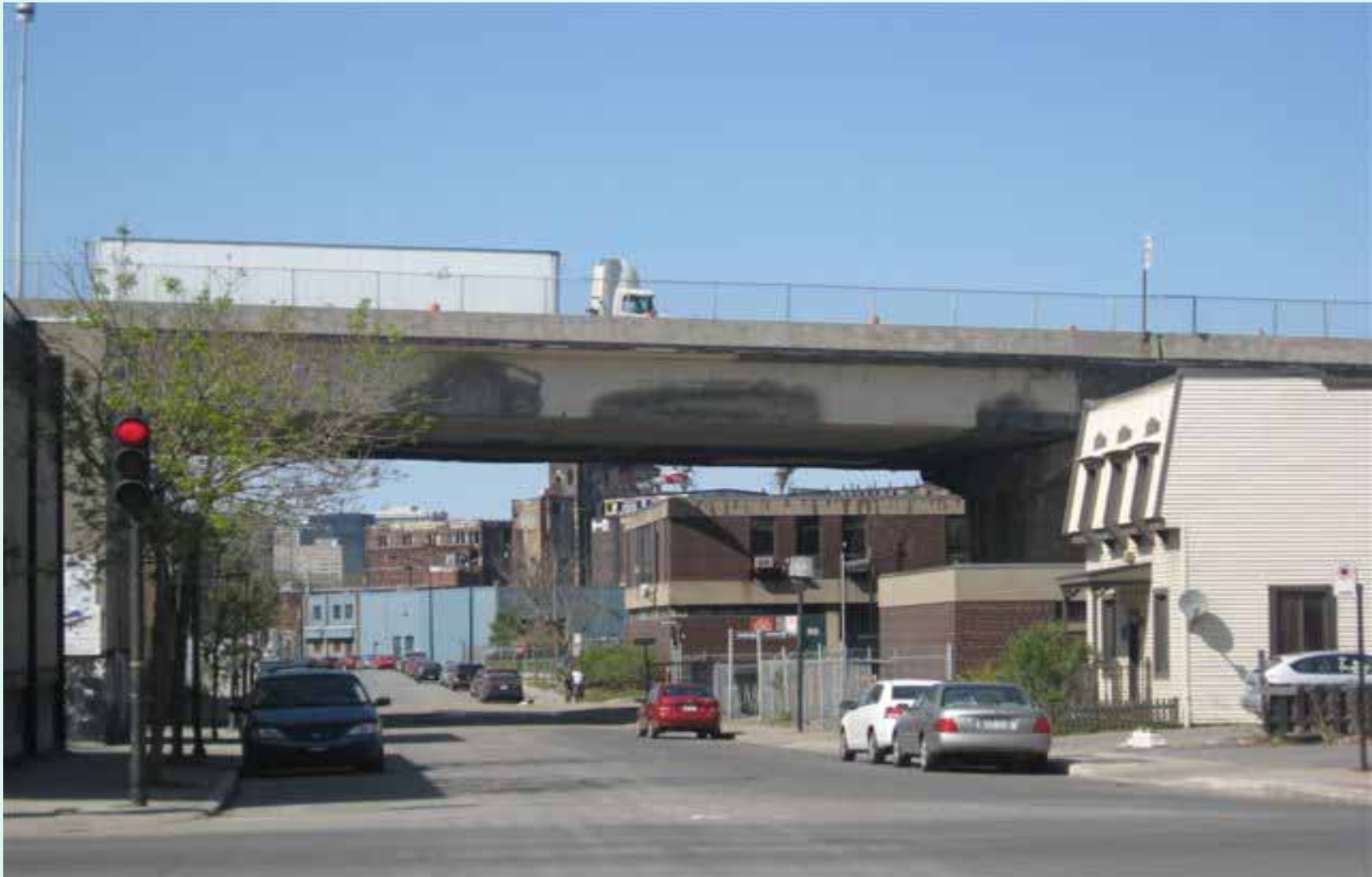
Rue Eadie, future rue barrée
